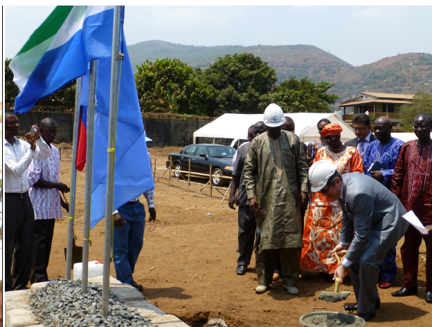
Рис. 27. Закладка фундамента г-ном А.В. Брегадзе
